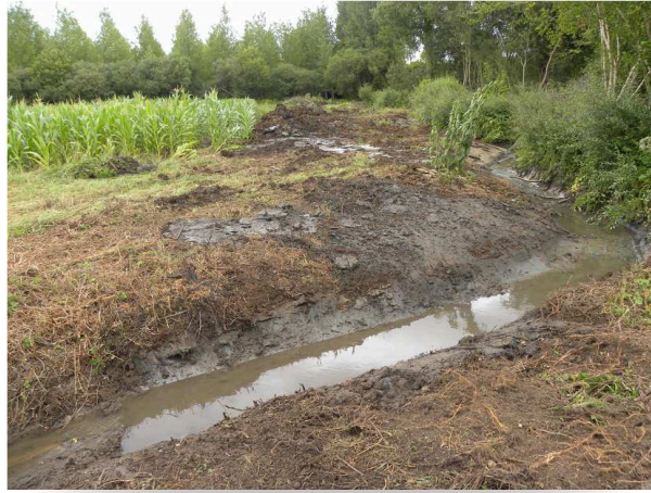
Débroussaillage et réouverture de l'ancien lit (ajustement du gabarit aux nouveaux écoulements) en diversifiant les profils en travers.
