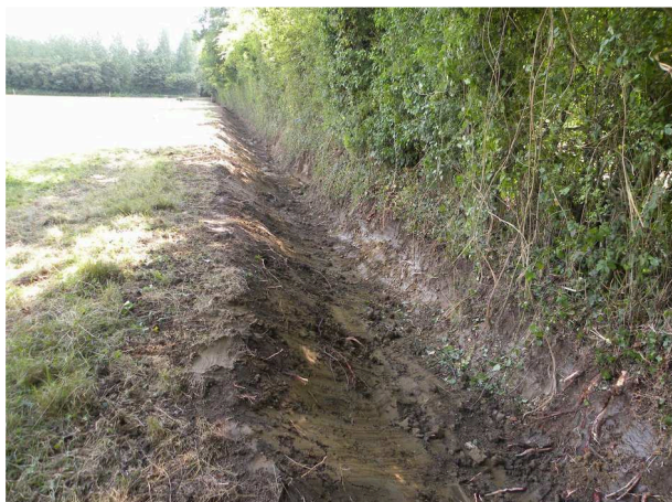
Vue du fossé après remodelage (augmentation de la section) (2015)
