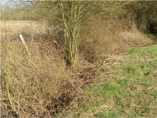
Avant travaux. Ancien lit de la Mème très largement "atrophié" par le manque d'écoulement (détournement du débit en amont).
