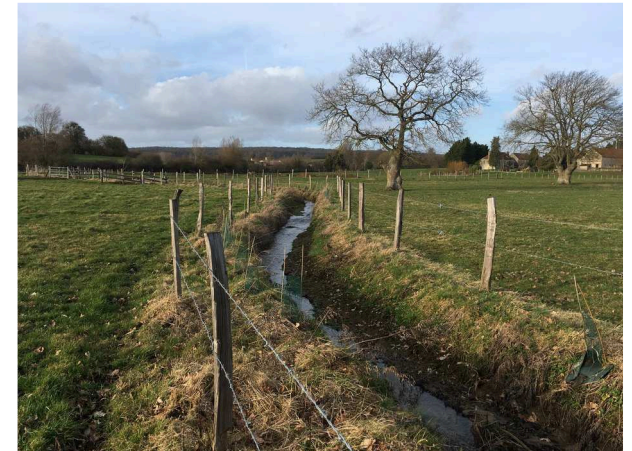
Évolution du nouveau lit 16 mois après la fin des travaux (février 2017). La végétation reprend ses droits et le lit mineur semble se redessiner doucement. Un nouvel apport en granulat serait toutefois intéressant car le milieu reste assez homogène.
