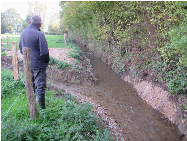
A la fin des travaux, comme pour le nouveau lit de la Calabrière, la zone de confluence manque de granulats (comme le lit de la Mème au dessus, voir planche suivante).
