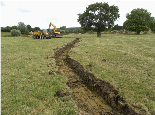
Avancement du creusement du lit. Malgré un exploitant compréhensif est intéressé, il n'a pas été possible de créer une sinuosité plus prononcée.
