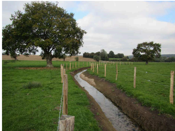
Nouveau lit terminé (automne 2015). Le lit primaire, préalablement creusé, a ensuite été modifié en évasant un peu les berges selon des pentes variables (plus douces à l'intérieur des courbes). Une recharge en granulats a ensuite été effectuée. L'ensemble du nouveau lit a été traité de cette façon. La quantité de recharge s'est finalement révélée insuffisante pour correctement diversifier les habitats. Nous verrons si le temps peut faire son œuvre ou si il doit être envisagé de compléter les apports en matériaux grossiers ultérieurement.
