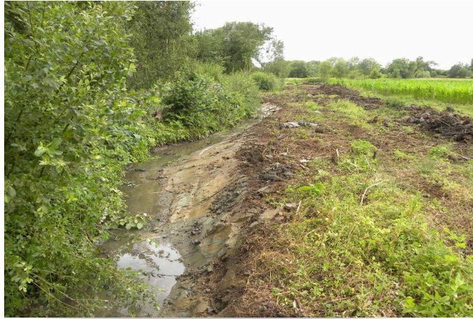
Remodelage du lit après débroussaillage. Une diversification des pentes des berges est appliquée (plus douce à l'intérieur des courbes, assises pour la recharge du lit en banquettes latérales).
