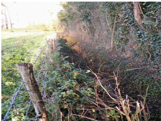
Avant travaux, présence du fossé qui coule de manière quasiment permanente.
