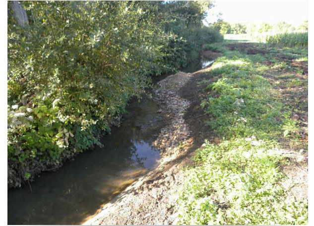
Apport de granulats terminé. Vue vers l'aval. L'apport s'est fait un peu au fond mais surtout en berge, avec un dépôt en attente de reprise par les écoulements.
