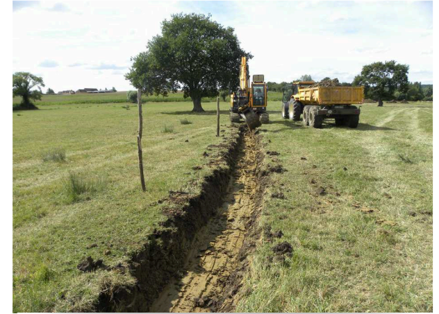
Creusement du lit (2015) : La pelle réalise d'abord un lit primaire de section rectangulaire à l'aide du godet. Une benne avec tracteur se charge de récupérer les déblais.
