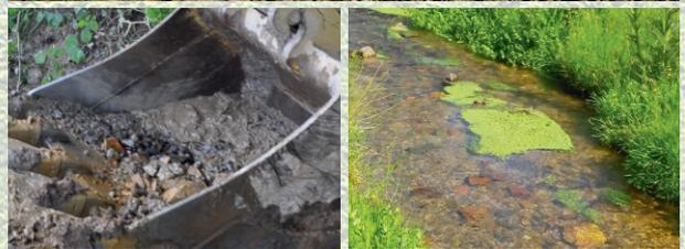
En haut : Sinuosité, berges basses, recharge hétérogène, seuils, mouilles et banc de convexité, bois mort : facteurs de diversité du milieu nouvellement formé. Ruisseau de la Croisette, Saint-James (50). À gauche : Reprise des matériaux du bief (Le Soquet, 50). À droite : Développement rapide de la végétation aquatique typique des eaux courantes (ici des callitriche) peu de temps après les travaux (La Sinope, 50).
