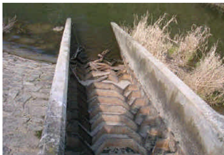
O19 : Passe à ralentisseurs de fond sur la Mayenne ; Barrage Bermondère à Couterne (61)
