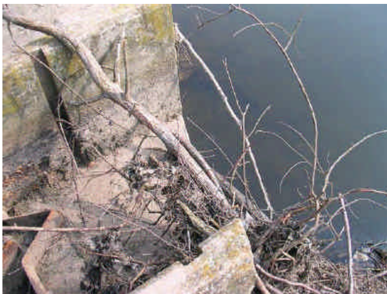
O19 : Passe à ralentisseurs de fond sur la Mayenne Barrage Bermondrière à Couterne (61)
