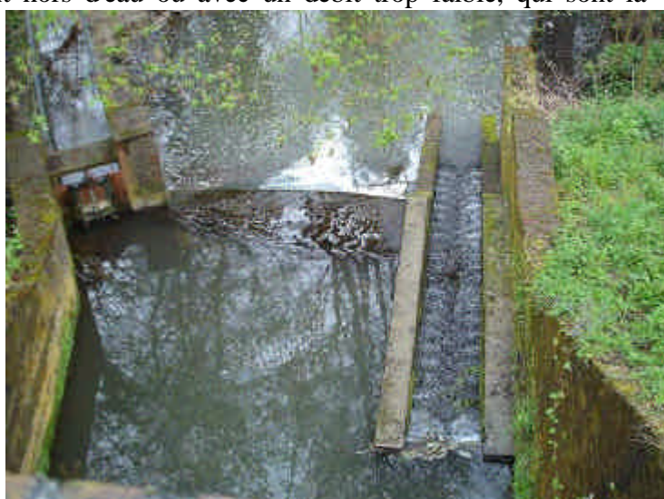
C19 : Passe à ralentisseurs de fond sur le Douet de la Taille Barrage du moulin à Coudray-Rabut (14)
