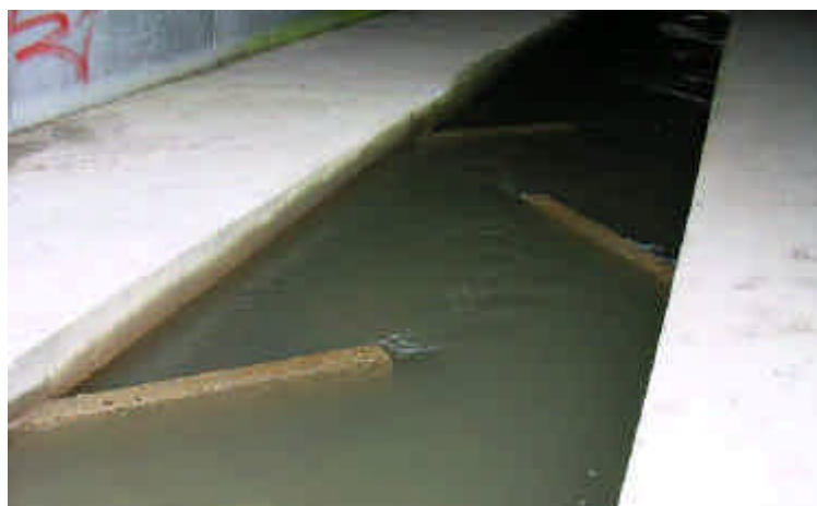
C65 : Passe en épis sur la Seulles Pont A84 à Coulvain (14)
