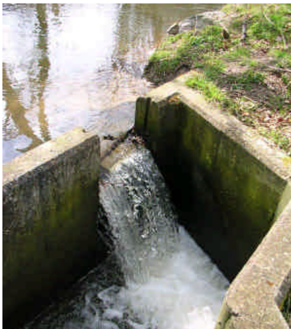
C57 : Passe à ralentisseurs de fond sur l'Odon Barrage de l'Abbaye à Aunay-sur-Odon (14)
