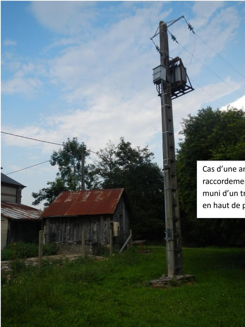
Cas d'une antenne de raccordement (en orange) muni d'un transformateur en haut de poteau.
