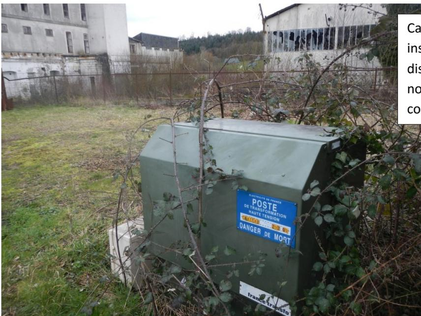
Cas d'un transformateur installé au sol. Remarque : dispositif récent, normalement non concerné par les PCB
