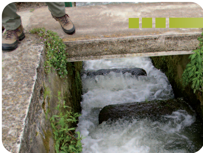
Certains dispositifs de franchissement construits par le passé apparaissent aujourd'hui comme vétustes et peu efficaces à l'image de cette passe à petit-bassin sur la Meuse.
